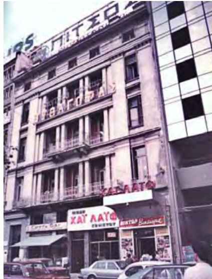
Εικ. 30. Μεταπολεμική όψη του κτιρίου με το Σινέ «Χάι-Λάιφ», το Bar-Cafe «Χάι-Λάιφ», το «Corfu Bar» στο ισόγειο και την Τεχνική Σχολή «Πυθαγόρας» στους ορόφους. (Πηγή: estia.minenv.gr)
