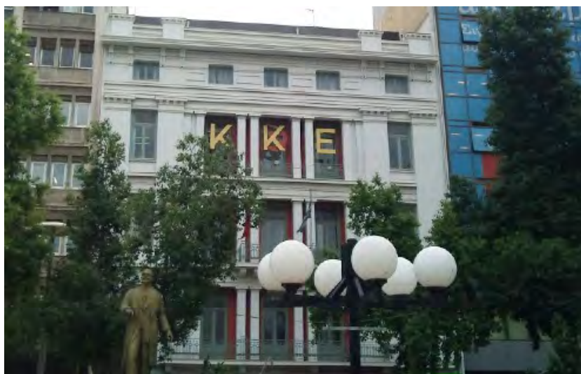
Εικ. 32. Το κτίριο την περίοδο που στεγαζόταν το ΚΚΕ (Πηγή: pireastime.gr).
